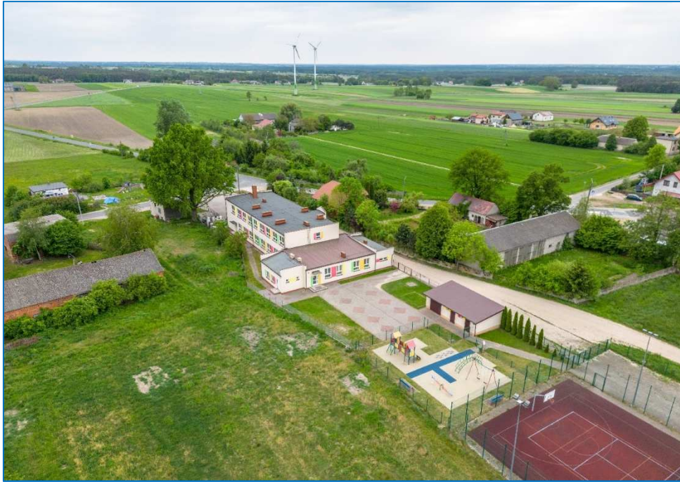
Fot. 3. Budynek SP w Miłaczewie wraz z placem zabaw i fragmentem kompleksu sportowego typu Orlik. Źródło: ze zbiorów Szkoły Podstawowej w Miłaczewie, 2024.
